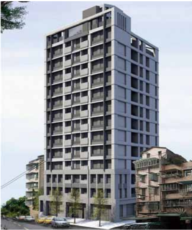
更新後提升建築品質
