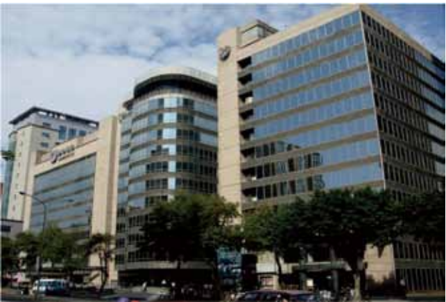
原聯合報大樓結構老舊已無法滿足地區發展需求
