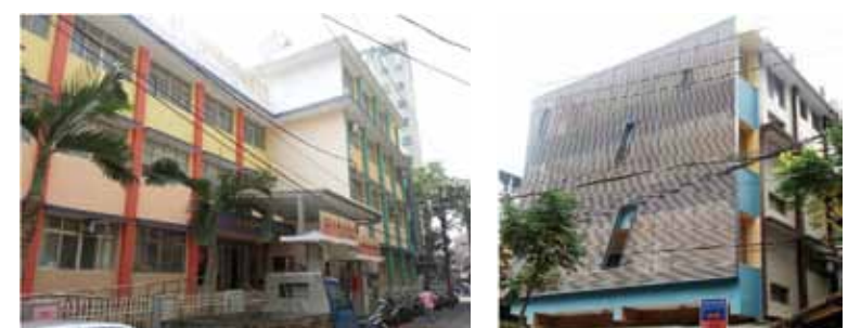
永和興公共托育中心整建維護後
